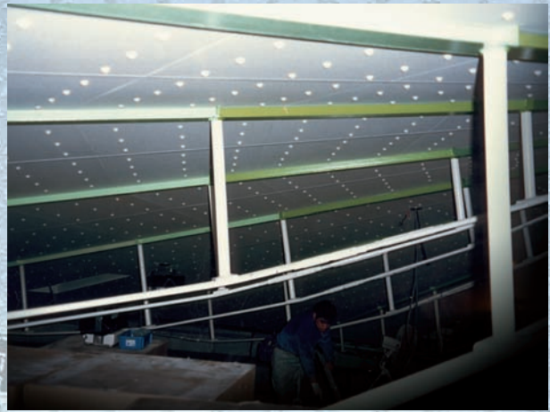
プラスチックボタンワッシャー施工例
