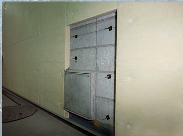
SPアンカー施工例
