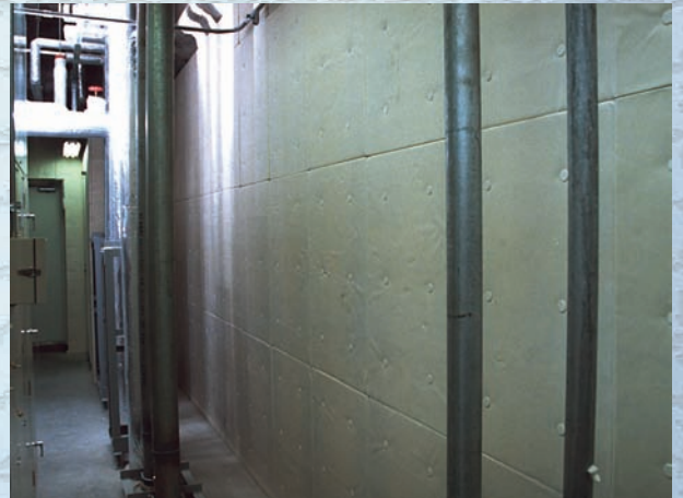
SPアンカー施工例
