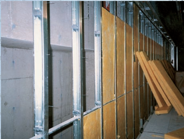
L形ピン施工例
