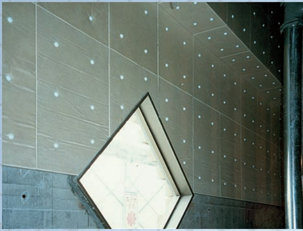
プラスチックボタンワッシャー施工例
