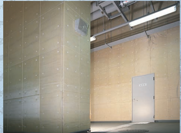
SPアンカー施工例
